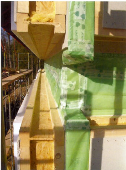
Obr. 7: Spojení parozábrany v oblasti stropů nad přízemím
