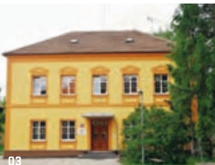
02, 03 > Budova před rekonstrukcí a po ní – byla vyměněna okna, proběhlo zateplení obvodového pláště
