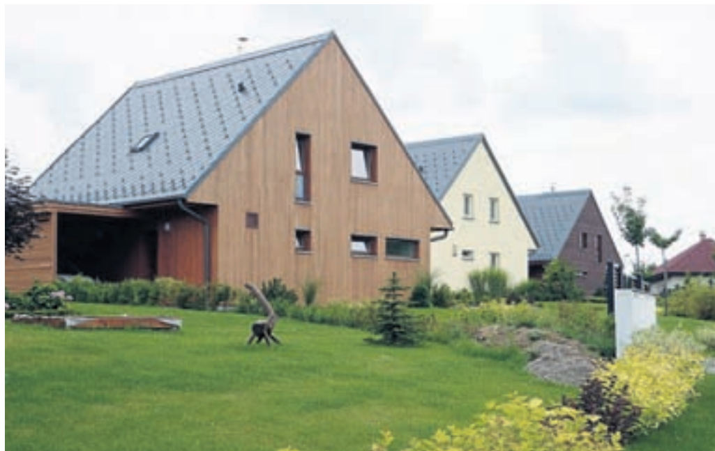
Úsporná „náves“ Dvanáct pasivních domů v Koberovech je už obsazených.
