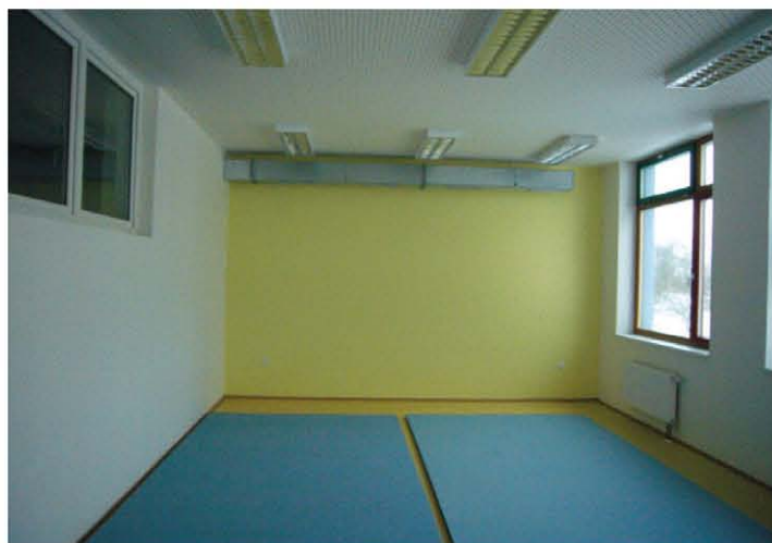
Rozvody vzduchotechnického potrubí byly ponechány bez zakrytování jako nedílná součást techniky budovy.
