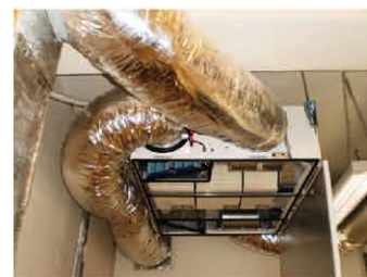
Fotografie z instalace větrací jednotky s rekuperací tepla.
