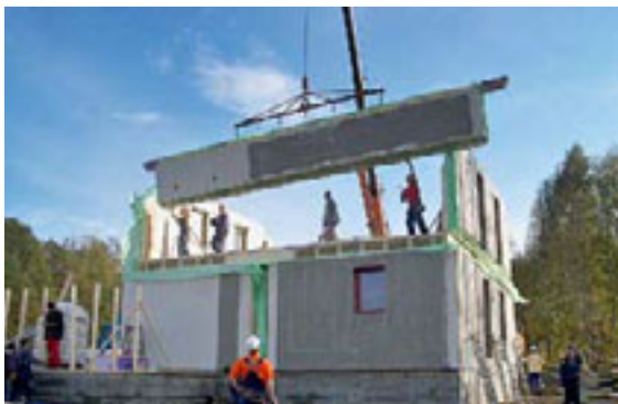
Celý dům je postaven z prefabrikovaných panelů se speciálním zateplením a byl hotov za tři týdny (stavba RD RÝMAŘOV, vzduchotechnika ATREA)
