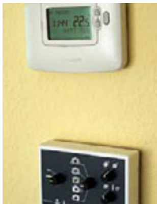
Centrální regulace vzduchotechnického systému na stěně obývacího pokoje
