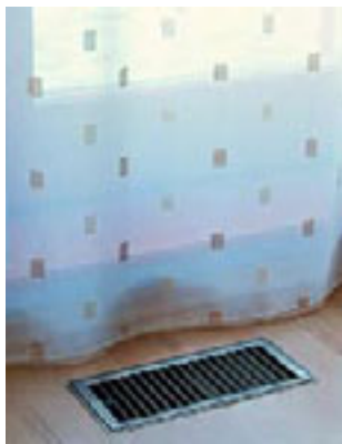
Vedení teplého vzduchu z rekuperační jednotky má výdechy v podlaže pod okny
