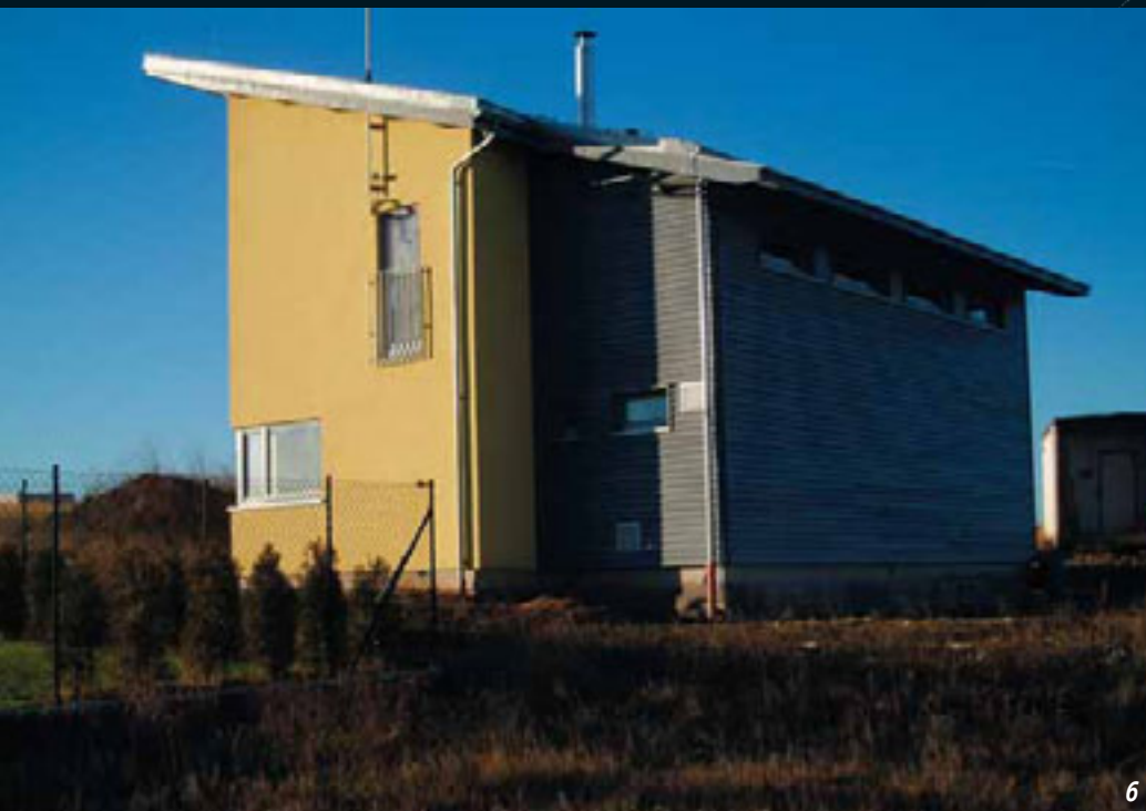
6 Příklad vyústění žaluzií systému na fasádě dřevěného nízkoenergetického domu (projekt autora)
