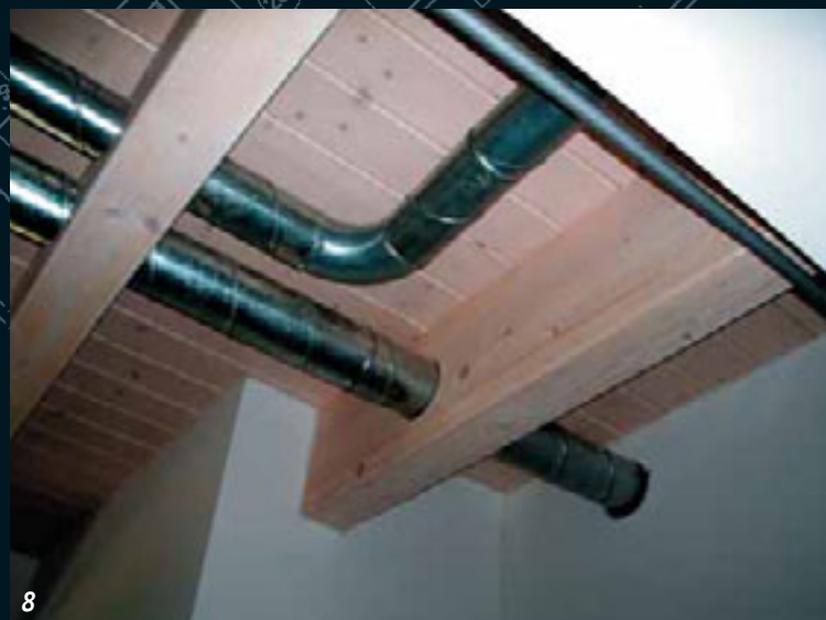
8 V Německu je obvyklé vedení rozvodů nuceného větrání pod stropem bez zakrytí podhledem jako součást interiéru
