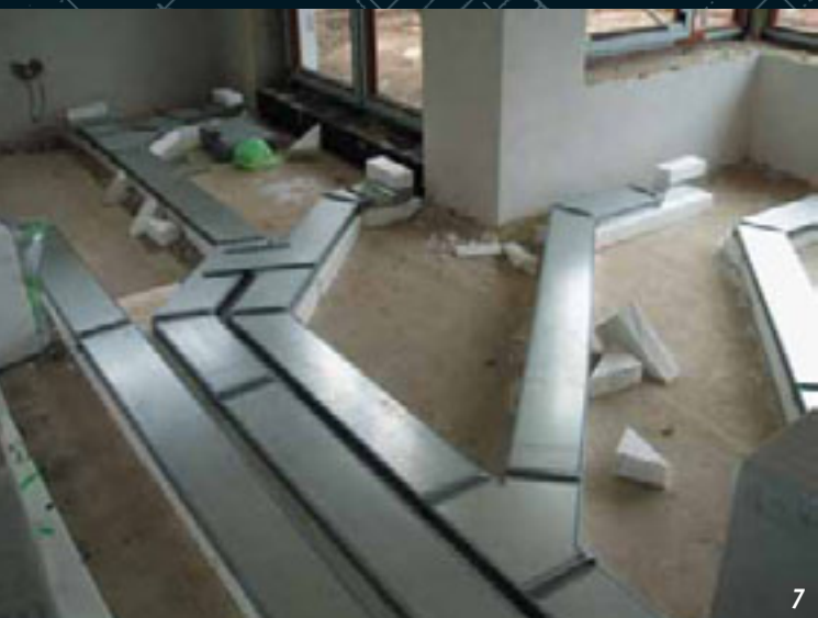
7 Ukládání rozvodů vzduchotechniky v plochých kanálcích v přízemí dřevěného nízkoenergetického domu
