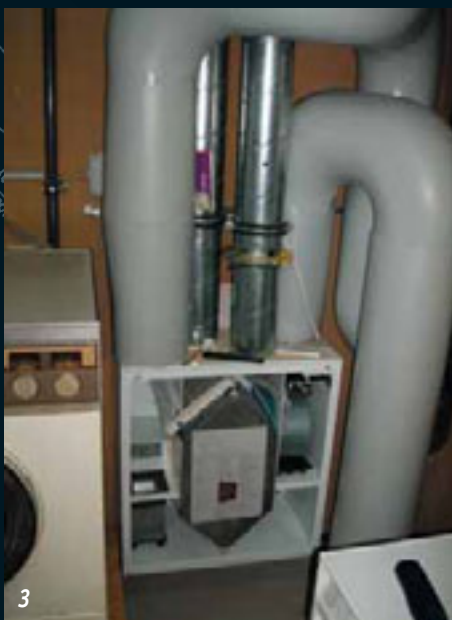
3 Pohled do otevřené rekuperační jednotky
