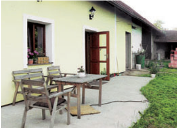
Rekuperace v rekonstruované venkovské chalupě, Myslíč u Benešova
