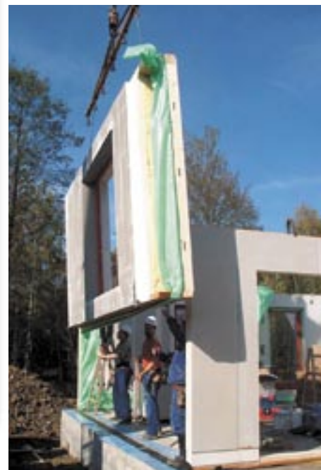
Dřevostavba byla smontována ze sendvičových panelů vyrobených v továrně a dovezených na stavbu již v hotovém stavu
