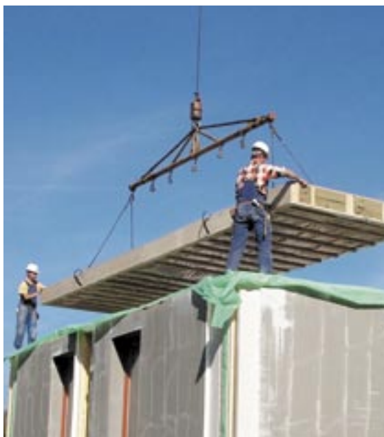
Panely šikmého a vodorovného stopu podkroví byly na místě před osazením krokvi a položením střešní krytiny doplněny vrstvami tepelné izolace
