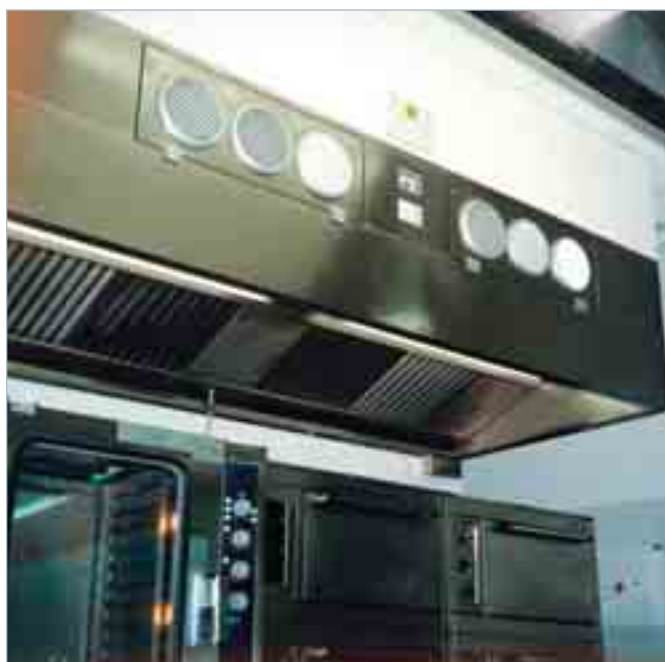
Obr. 14 Nová koncepce kuchyňských digestoří s vestavěnou rekuperací tepla a automatickou regulací
