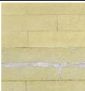
Kvalitní řemeslné provedení všech detailů je podmínkou úspěchu při stavbě nízkoenergetického domu. Podíl vlivu případných tepelných mostů na celkových energetických ztrátách objektu narůstá úměrně s tloušťkou tepelněizolačního materiálu.
