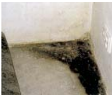
Plošný rozvoj plísní z vlhké zdi pod podlahovou krytinu – koberec
