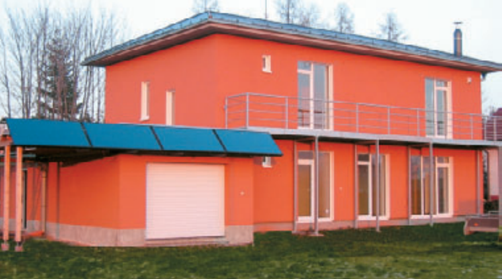
Dům F před dokončením (J. Tywoniak a kol., spolupráce M. Šenberger, 2004) – potřeba tepla na vytápění 30 kWh/(m 2 a). Před velkými okny v patře budou ještě osazeny pojezdné stínící lamelové prvky.
