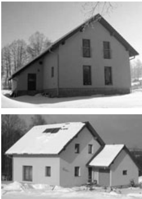
Obr. 1 a, b Pohledy na dům
