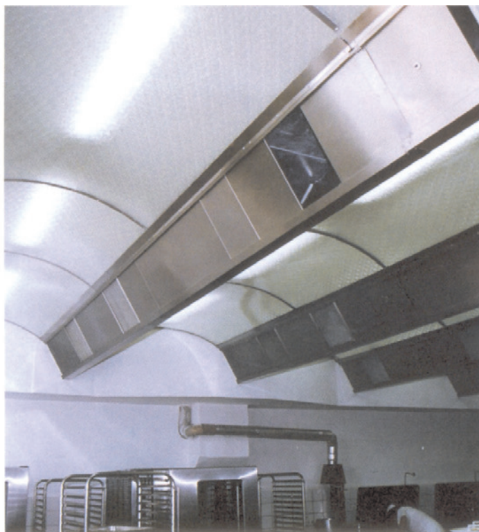
■ Odsávací vzduchovody s kazetovými tukovými filtry.
