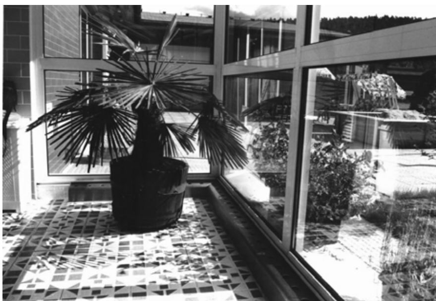
obr. 3 Přivodní štěrbinové výústky ve sníženém parapetu okna
