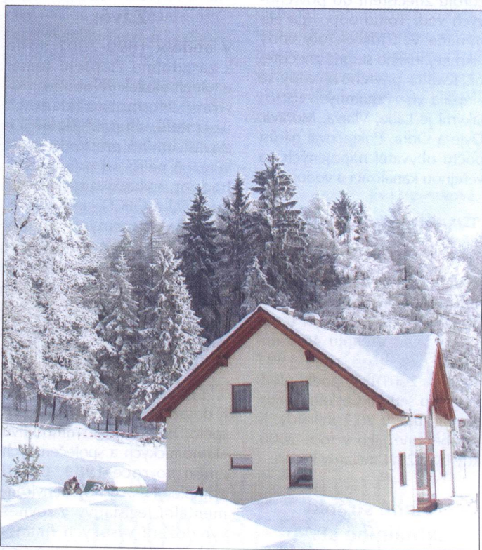
Nízkoenergetický dům Koberovy
