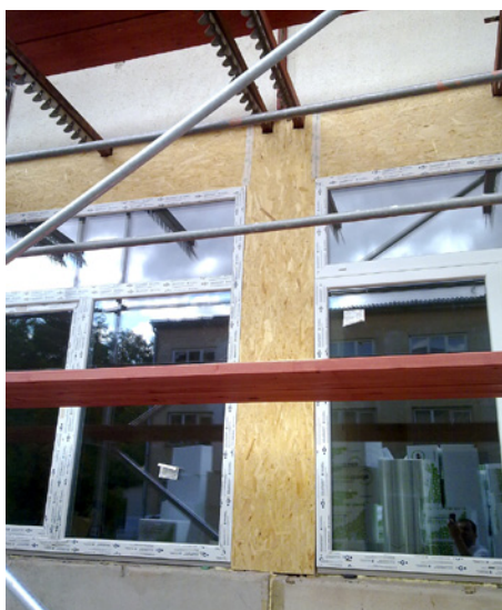
6 Výměna boletických panelů za konstrukci používanou v dřevostavbách
