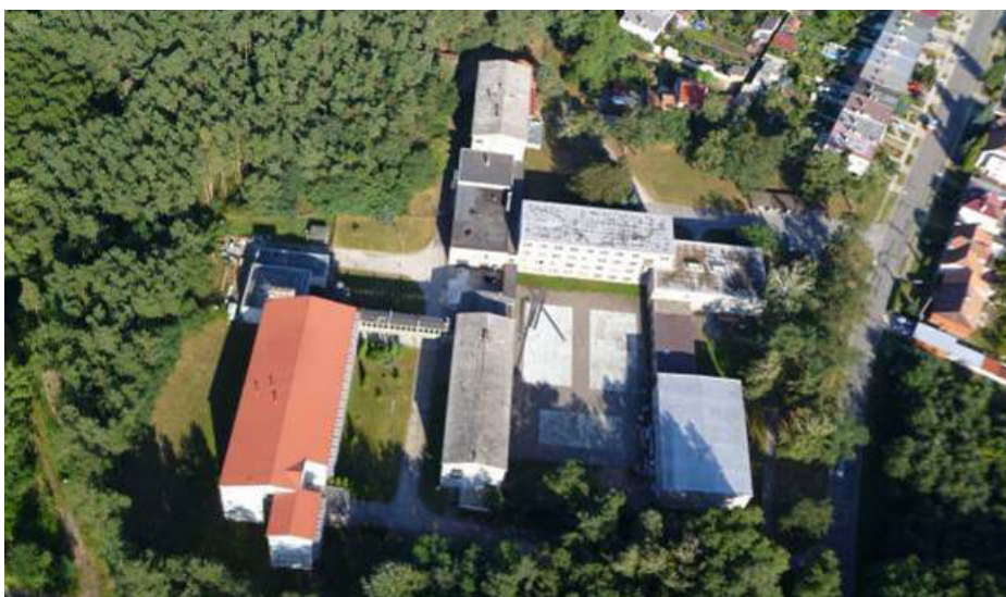
4 Letecký pohled na areál s již opraveným bytovým domem
