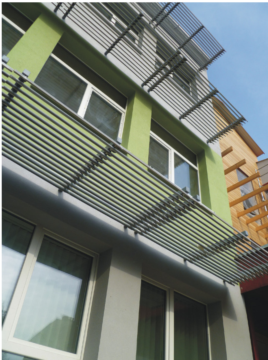
8 Stínění zamezuje přehřívání interiéru v letních měsících
