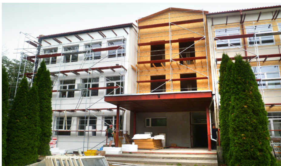
6 Výměna boletických panelů za konstrukci používanou v dřevostavbách
