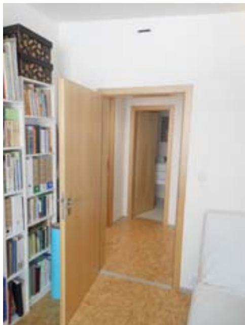
Štěrbina nad dveřmi je přiváděn vzduch pro větrání, chlazení nebo topení. Jiné technické zařízení v místnosti není
