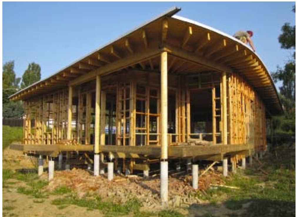
Položení kostry domu na betonové pilotky zavrhané do hloubky tří metrů bylo nutné kvůli nestabilnímu jílovému podloží. Toto řešení umožnilo založit stavbu bez zásadního navýšení ceny základů
