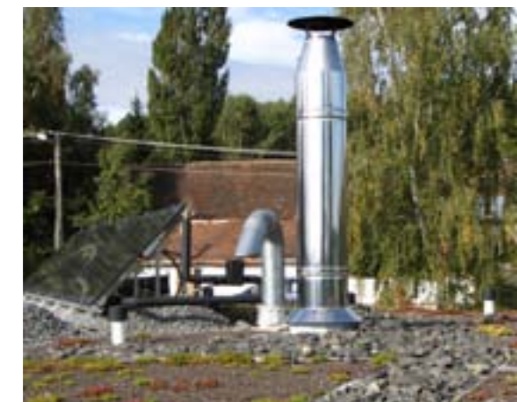
Pasivní dům je vybaven špičkovými technologiemi ohleduplnými k životnímu prostředí – v popředí je vidět komín, kvalitní solární kolektor a výfuk znečištěného vzduchu, dole je detail světlovodu
