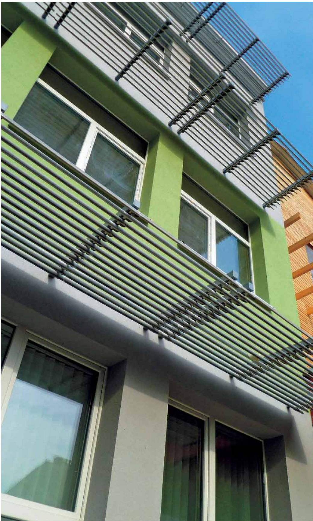
Zaujímavá a inšpiratívna je rekonštrukcia školy postavenej panelovou technológiou a kolaudovanej v roku 1989 na energeticky pasívny bytový dom s 27 bytmi. Objekt sa nachádza v Dubňanoch pri Hodoníne. Vetrание s rekuperáciou tepla bude zaisťovať centrálny systém. Výpočtová tepelná strata celej budovy s 27 bytmi je 38,8 kW, náklady na vykurovanie bytov podľa veľkosti sú od 36 – 80 €/byt a rok. (foto: Atrea)
