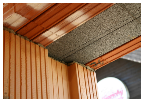
Detail uložení nosných překladů
